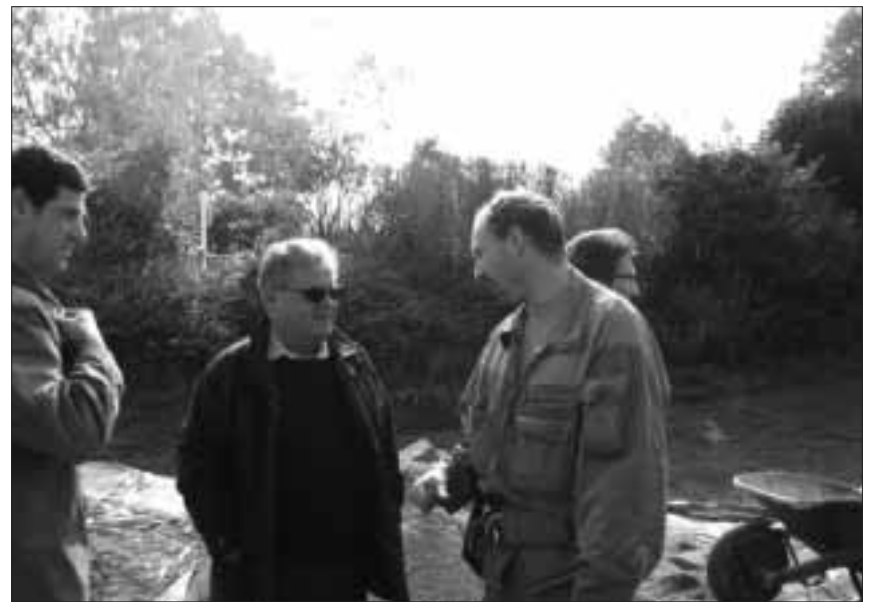
Gemeinderat Bruno Gehrig besuchte die Zivilschützer bei ihrem Einsatz im Sonnenbad. Die Umgebung und die Mauer beim Brunnen im Gebiet Herzogenmatte wurden komplett erneuert
