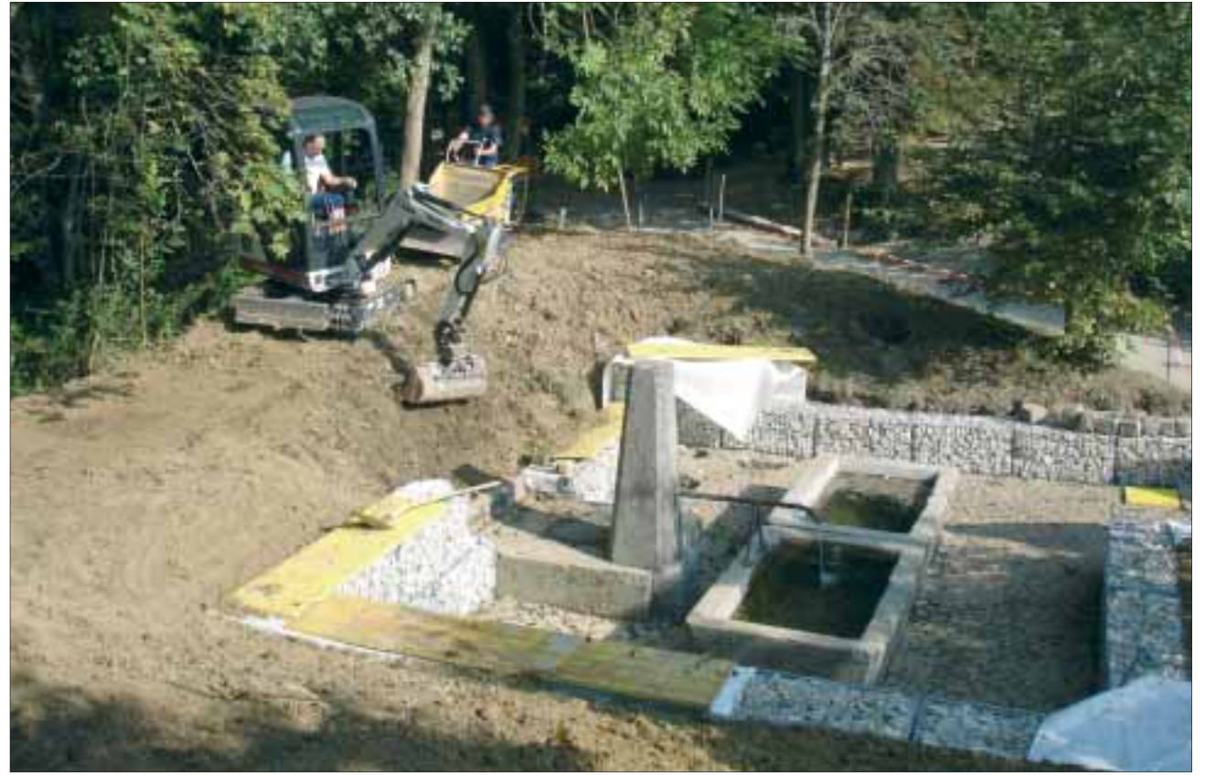
Brunnenanlage: Die Umgebung wurde durch den Werkhof erneuert.
