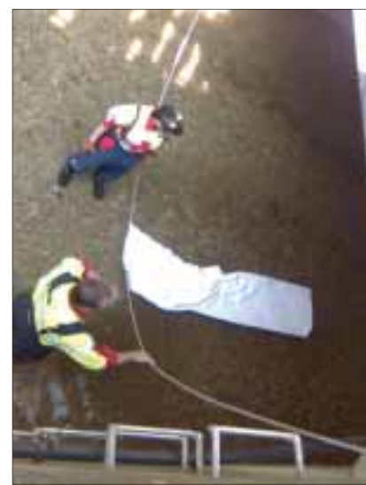
... zur Errichtung der Sperren mit speziellen Tüchern, welche einen allfälligen letzten Oelfilm aufnehmen würden.
