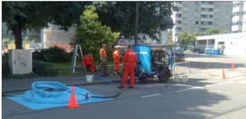
Übung in der Stadt: Notwasserversorgung aus einer Grundwasserdole.
