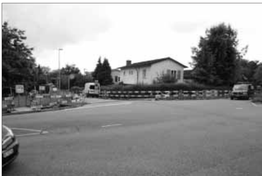
Wegen der Baustelle in der Paradiesstrasse wird der Verkehr über die Langegasse umgeleitet. Foto: Urs Niederhauser
