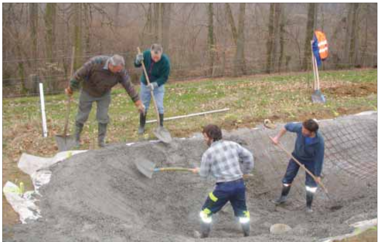
Betonierter Weiher: Sind praktischer bei dem Unterhalt und für die Natur nützlicher.
