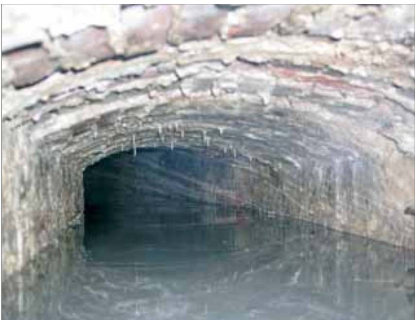
Seitengang: Eine erste, abenteuerlich in 8 m Tiefe und im 1,5 m hohen Wasser geschossene Foto, die den Blick in den Seitengang am Fuss des Sodbrunnens freigibt. Fotos: zVg
